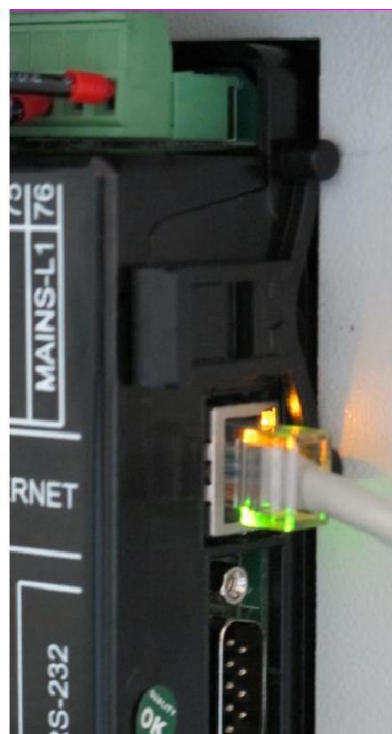
Установка кронштейна самостопорящего типа
